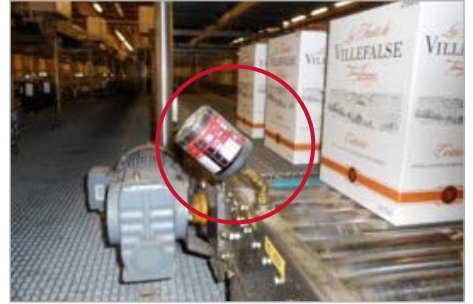
Schmierung einer Kette in einer Förderstrecke
