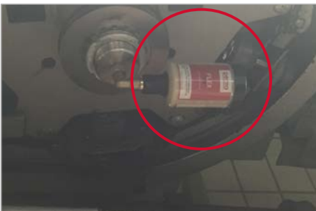
Schmierung des Antriebsrollenlagers an einem Ofen
