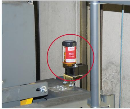
Schmierung der Führungsschienen an der Fahrgastkabine
