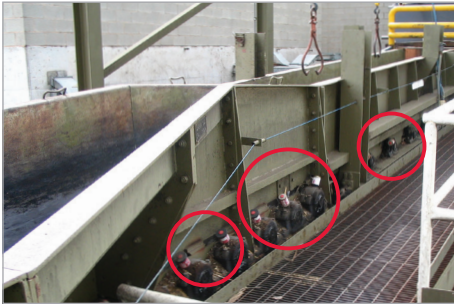
Lagerschmierung an der Baumsortierung
