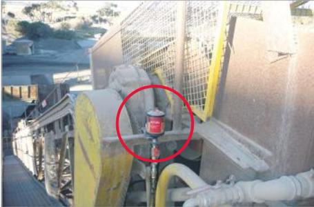
Stehlagerschmierung der Drucktrommel
