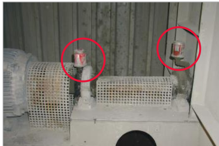
Schmierung der Antriebswelle am Gebläse
