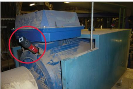
Motorschmierung einer Pumpe
