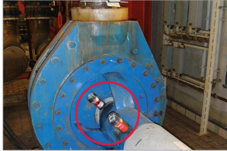
Antriebswellenschmierung einer Pumpe
