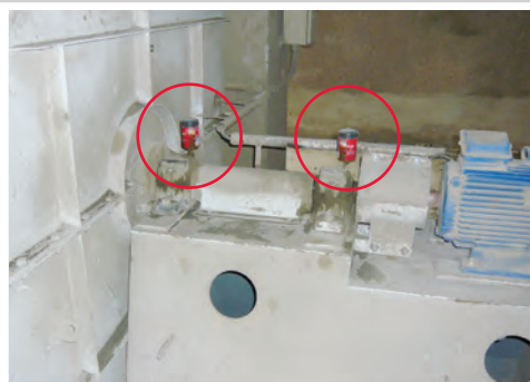
Stahlagerschmierung einer Lüfterwelle
