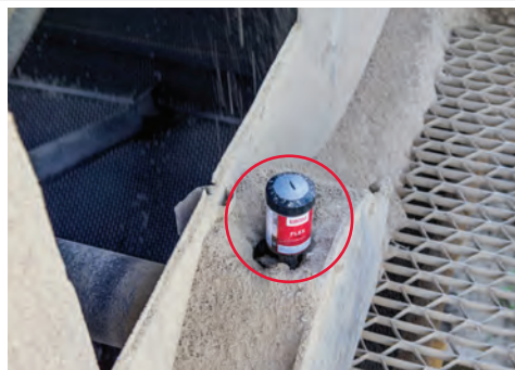
Stehlagerschmierung an Splitt- & Sandsieb
