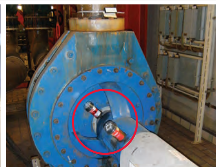
Antriebswellenschmierung einer Pumpe
