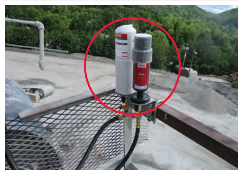
Stehlagerschmierung einer Förderbandanlage
